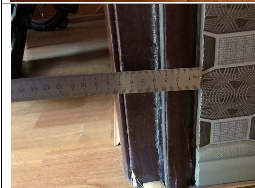
Фото №12. Дефект дверного наличника в спальне в квартире.
