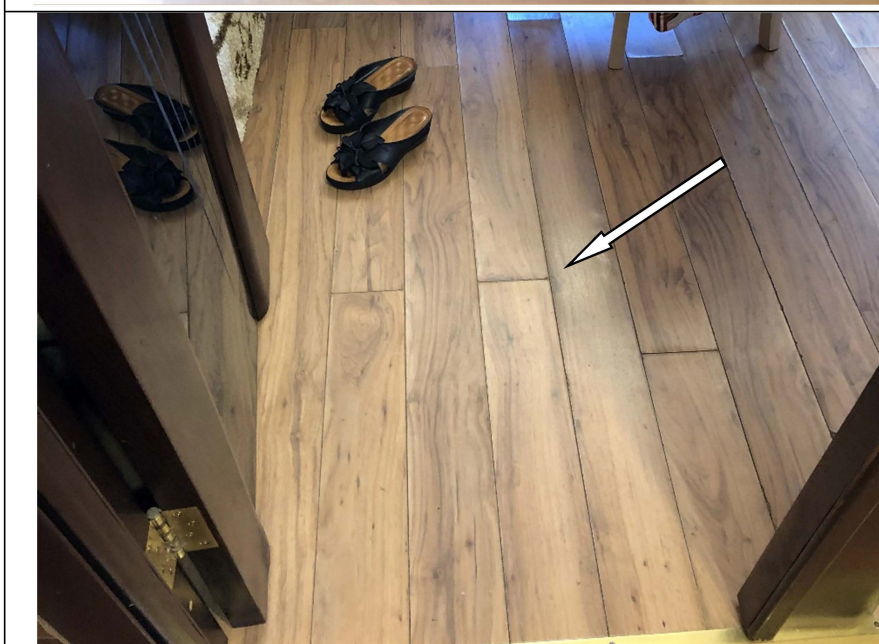
Фото №5. Общий вид напольного покрытия в общей комнате в квартире. Дефект ламината.
