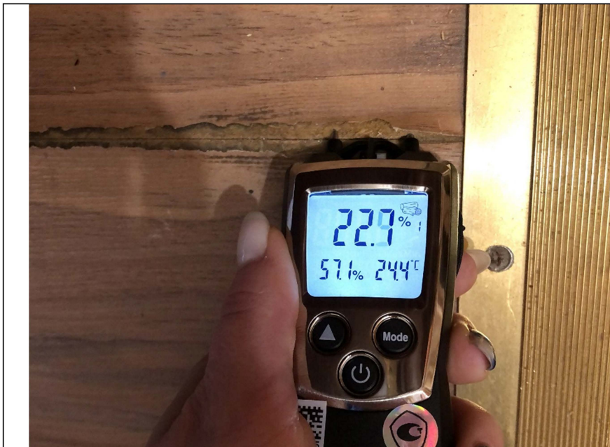
Фото №19. Измерение уровня влажности в напольном покрытии в общей комнате.
