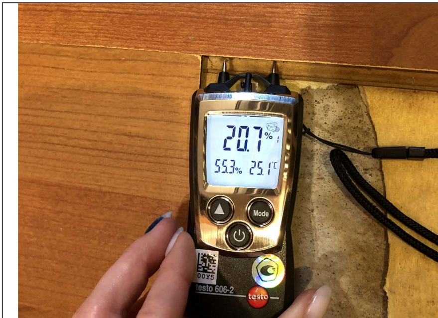
Фото №16. Измерение уровня влажности в напольном покрытии в коридоре.
