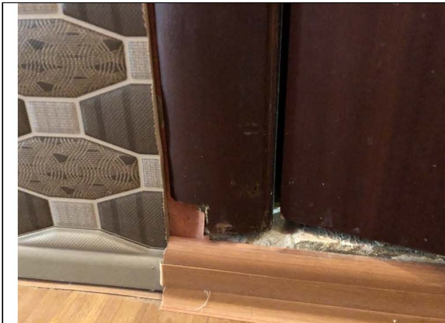
Фото №10. Дефект дверного наличника в санузле в квартире.
