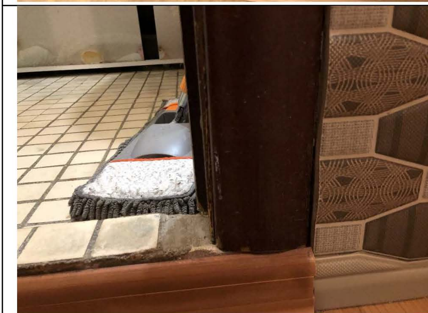
Фото №11. Дефект дверного наличника в ванной комнате в квартире.
