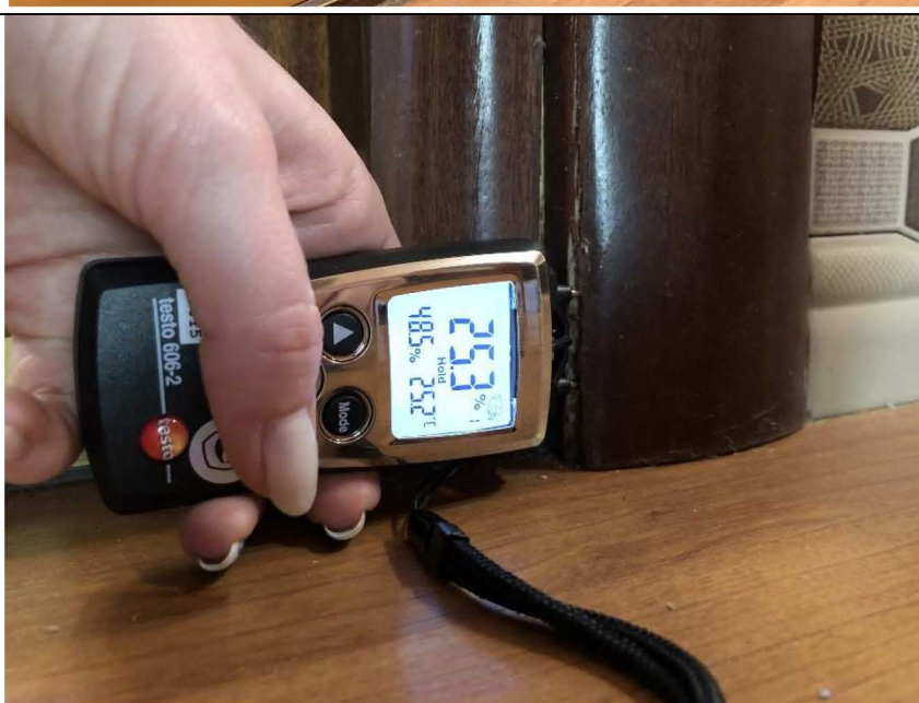
Фото №15. Измерение уровня влажности в дверном наличнике в кухне.
