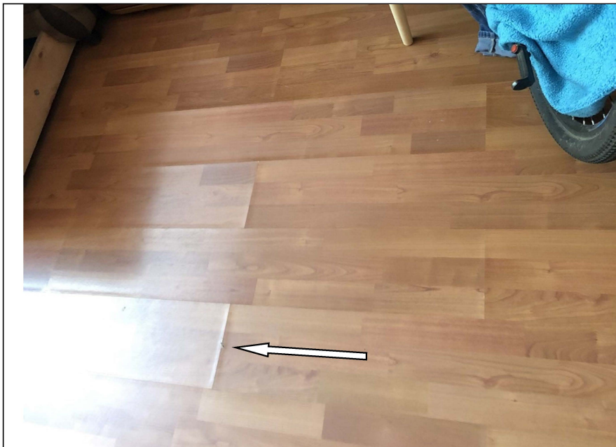
Фото №4. Общий вид напольного покрытия в спальне в квартире. Дефект ламината.
