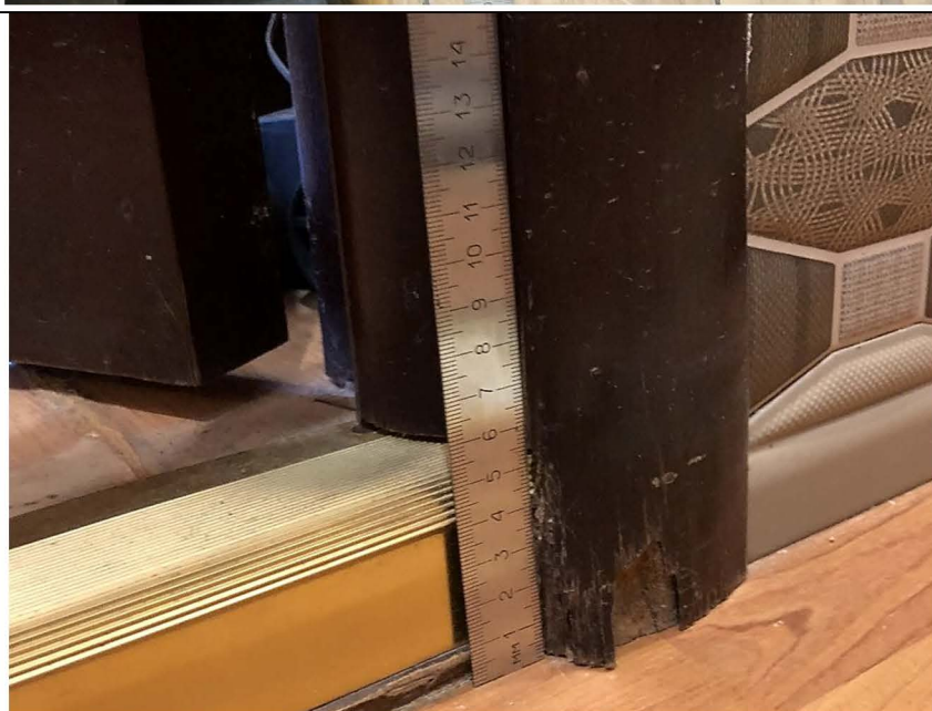
Фото №14. Дефект дверного наличника в общей комнате в квартире.
