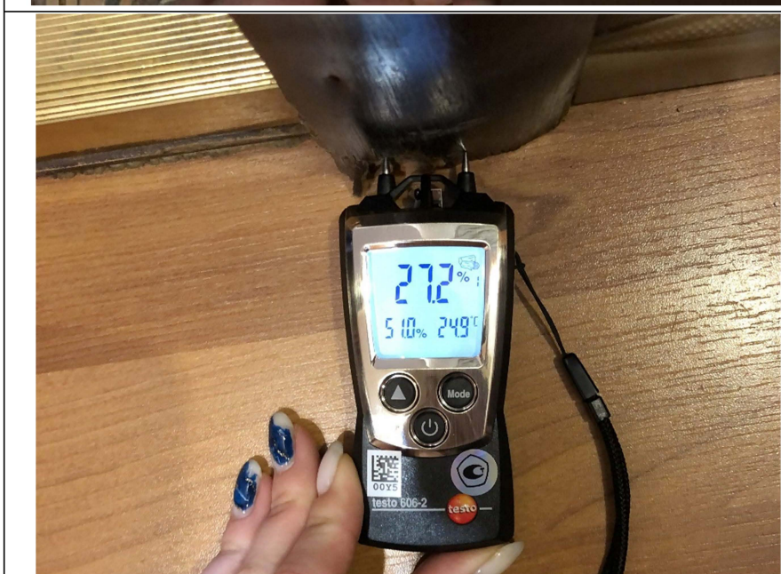
Фото №18. Измерение уровня влажности в дверном наличнике в общей комнате.
